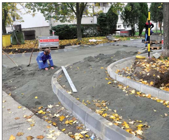
Opravou prochází také komunikace v ulici Budovatelská.
